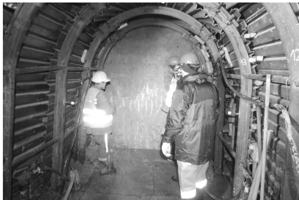
POHLED do obrovské štoly.
