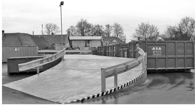
NÁJEZDOVÁ RAMPA ve sběrovém dvoře se nachází metr nad terénem, třídění odpadu proto bude pro lidi snadné. Foto: Archiv města
