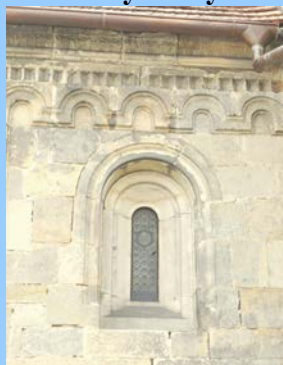
Vinec – jednoduché okno s obloučkovým vlysem
