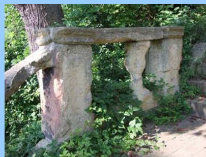
Balustrády lemující schodiště
