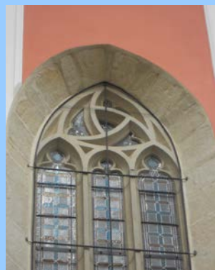
Detail okna s plaménkovými kružbami ve vrcholu lomeného
