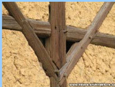
Hrázděná konstrukce
