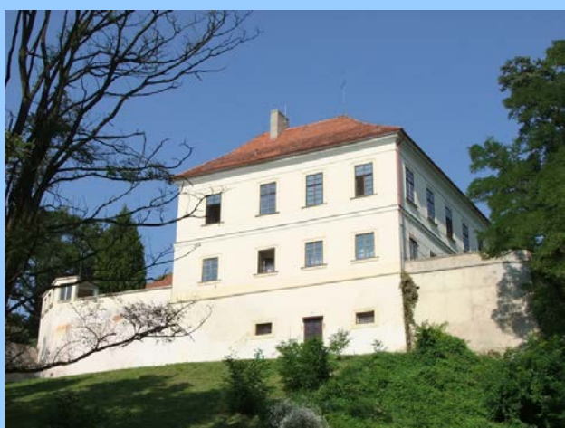
Barokní východní křídlo zámku stojí na vyvýšenině mohutných sklepních prostor
