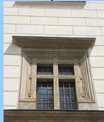
Jednoduché okno s dekorovanou šambránou zámek Hrubý Rohozec
