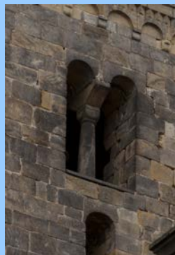
Mohelnice – sružené okno
