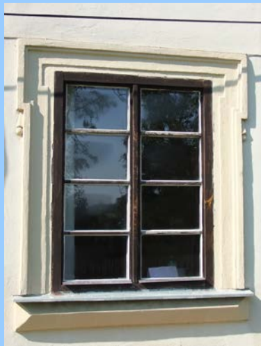
Barokní okno zámku s jednoduchou šambránou
