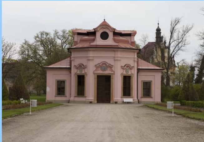
Salla terrena (hudební altán) zámeckého parku v Mnichově Hradišti
