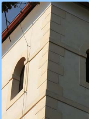
Bosované nároží věže zámku. Původní pískovcové nárožníky byly nahrazeny bosáží vyvedenou v omítce
